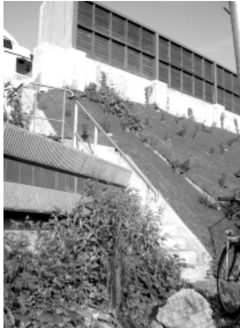
L'escalier dont doivent se contenter les cyclistes pour accéder à l'échangeur d'Hallennes-lez-Haubourdin
