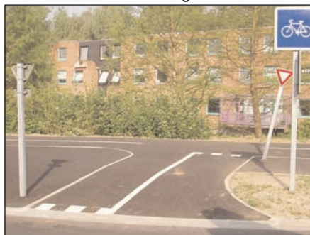
CG59 : seuils zéro pour les cyclistes et 2 cm pour les piétons à Villeneuve d'Ascq et à Wasquehal
