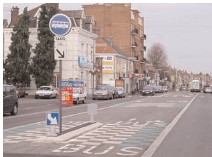
Voie bus-vélos de la Ligne à Haut Niveau de Service (ici rue A. Carrel à entre Lille et Ronchin)
