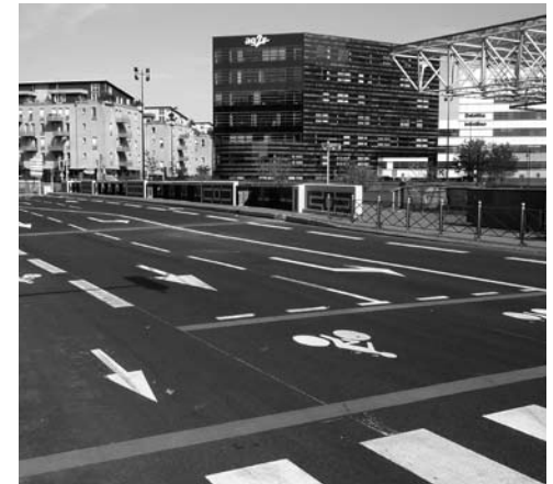
Lille, Pont d'Erfurt, suppression d'une voie et réalisation de bandes
