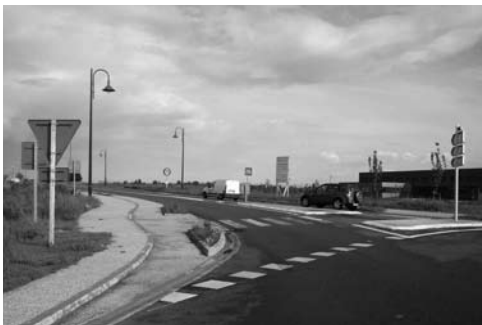
Cambrai, By-pass à l'entrée d'un giratoire
