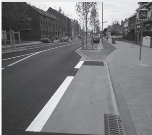
traversée de Seclin - chantier de réfection avec implantation de pistes cyclables
