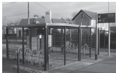
Le stationnement sécurisé dans les gares TER
